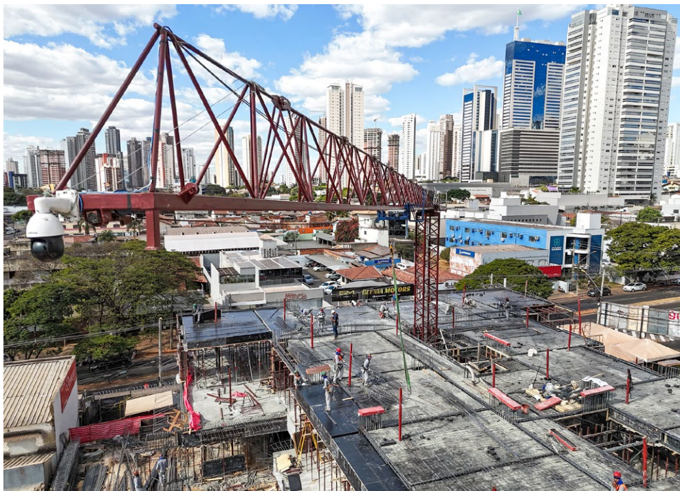
■ Câmera Speed Dome instalada na grua auxilia o operador do equipamento
