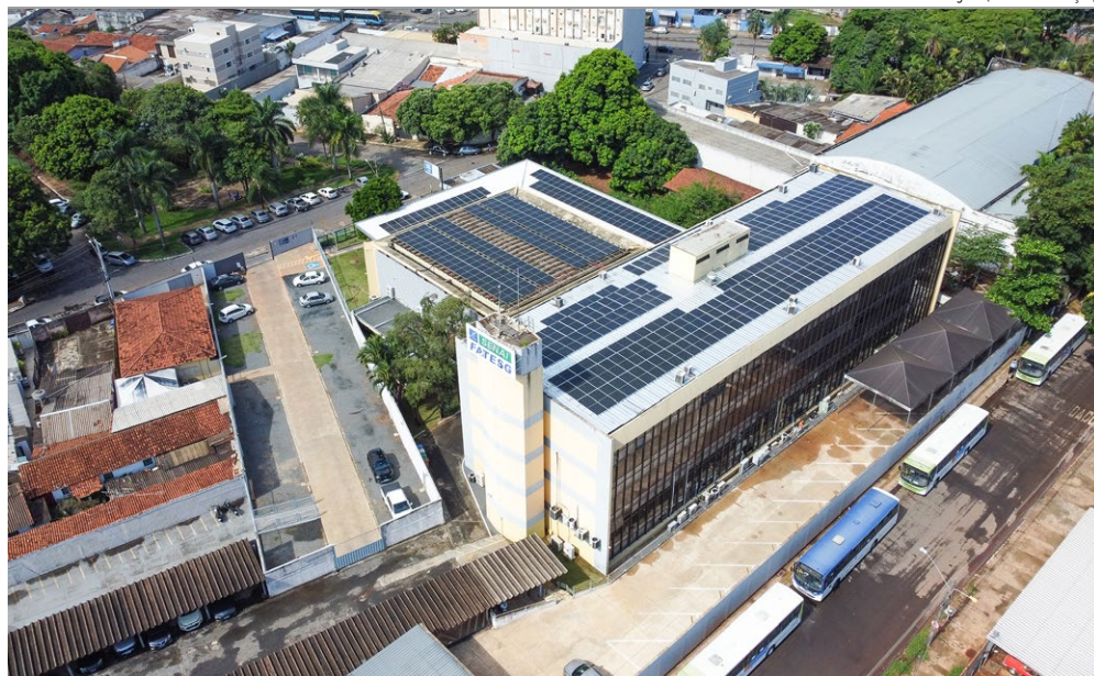
■ Faculdade Senai Fatesg, em Goiânia: recente reforma e ampliação inclui instalação de usina fotovoltaica com capacidade de gerar 325 megawatts hora por ano, capaz de atender 90% da energia consumida pela unidade
