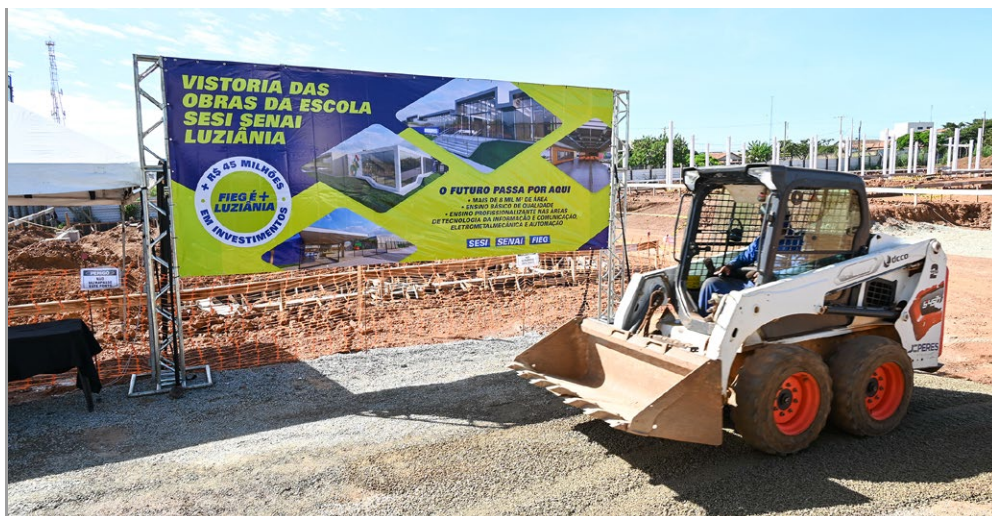
■ AQUI NASCE UMA ESCOLA! Obras da Unidade Integrada Sesi e Senai Luziânia avançam depois de vencer período de chuvas intensas
