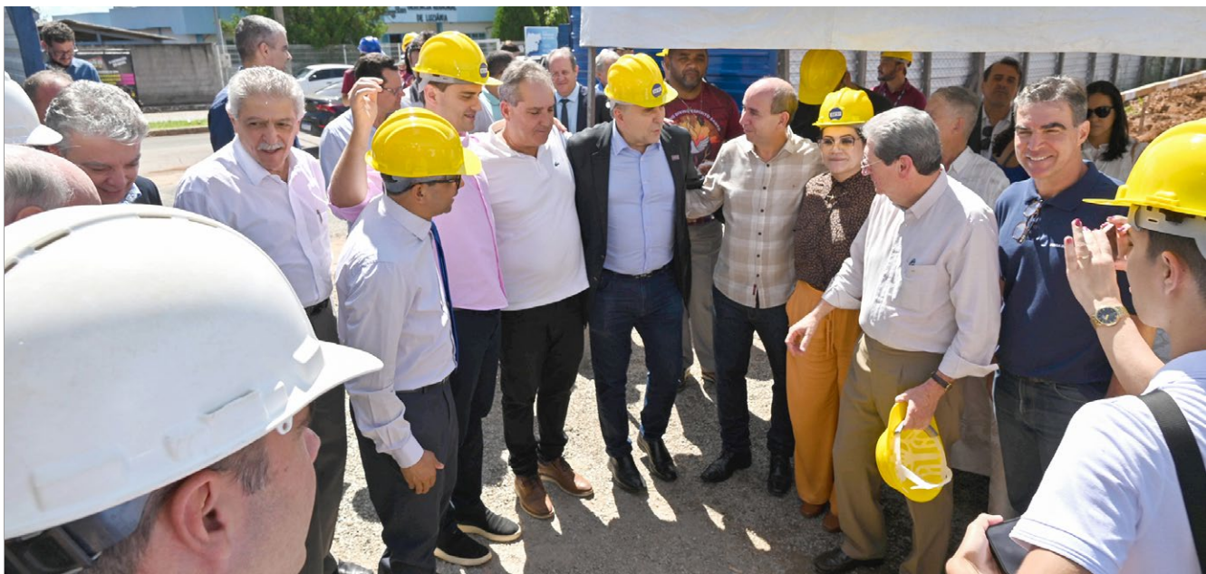
■ No canteiro de obras, empresários e autoridades participam da vistoria
