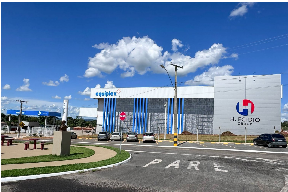
■ Novo Centro de Distribuição e expansão da indústria farmacêutica Equiplex , em Aparecida de Goiânia ▶
